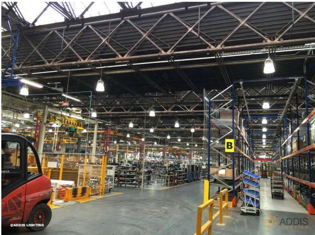
La cohésion des équipes d'Addis, du groupe ETN et des techniciens sur site ont permis de mettre en œuvre ce projet de grande envergure. Ce n'est pas moins de 250 armatures Quartz 150w 4000k avec cloche polycarbonate qui ont été installées sur ce site.
